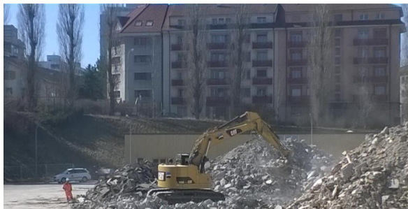
Staubintensive Bauarbeiten im Siedlungsgebiet
